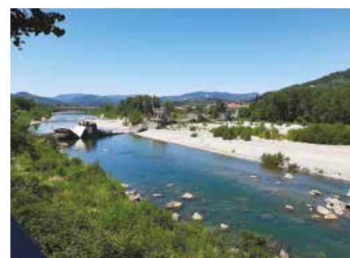
PONTE ALBIANO MAGRA ROVINE DEI NOSTRI TEMPI Fotografia di: SPAGGIARI FERDINANDO
