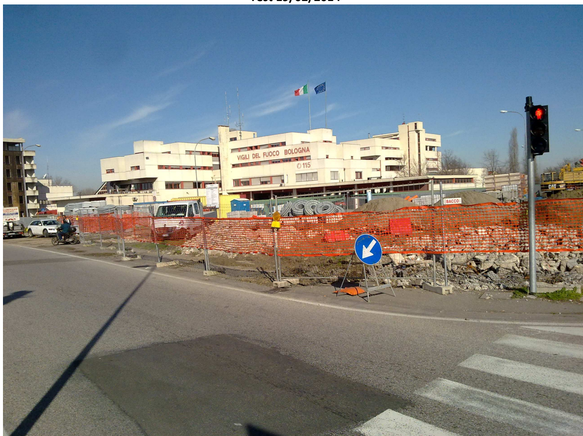
Fig. 5 – Segnaletica di cantiere in presenza di traffico
