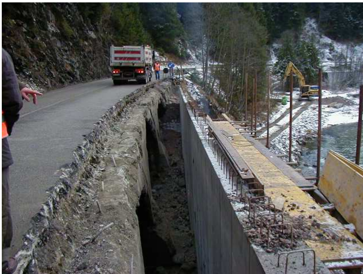
Fig. 4 – Posa muro di contenimento su strada provinciale
