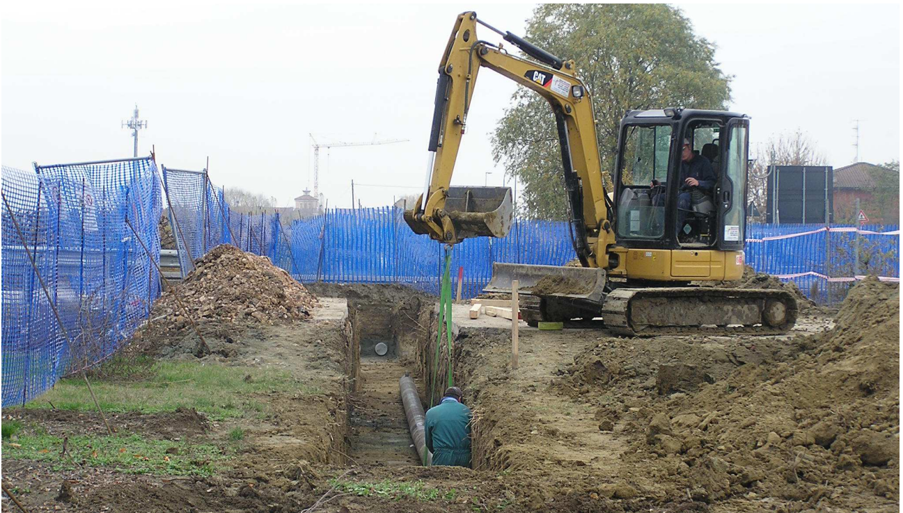
Fig. 2 – Posa in opera tubo per condotta gas
