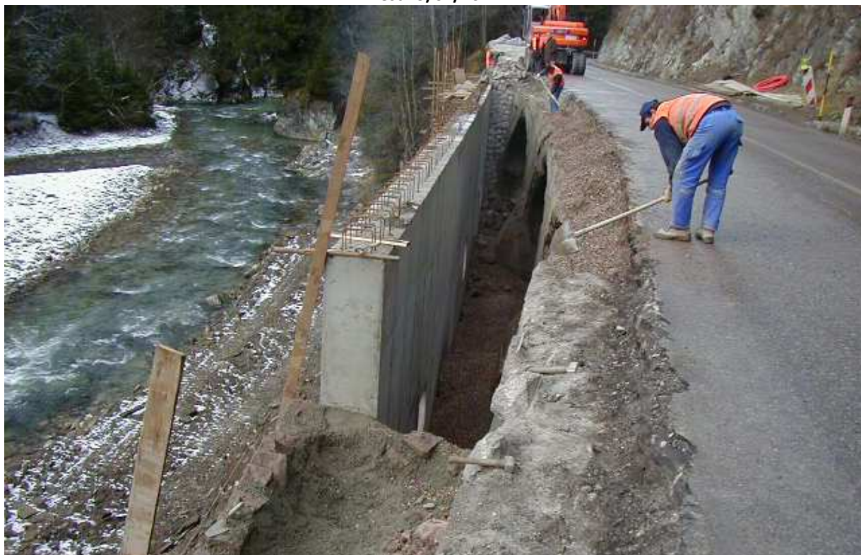
Fig. 3 – Posa muro di contenimento su strada provinciale
