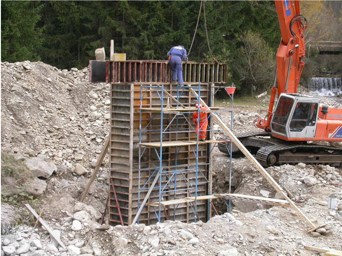
Foto n. 1 – Cantiere autostradale, costruzione di un setto pilastro
