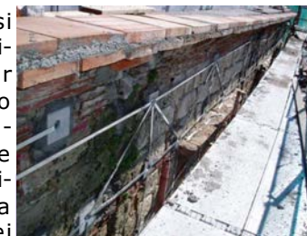
Cordolo tipo GIUFFRÈ, senza necessità di demolire la muratura e la copertura, realizzato con due correnti parallele e collegamenti diagonali. (Sant'Agata Militello ME)
