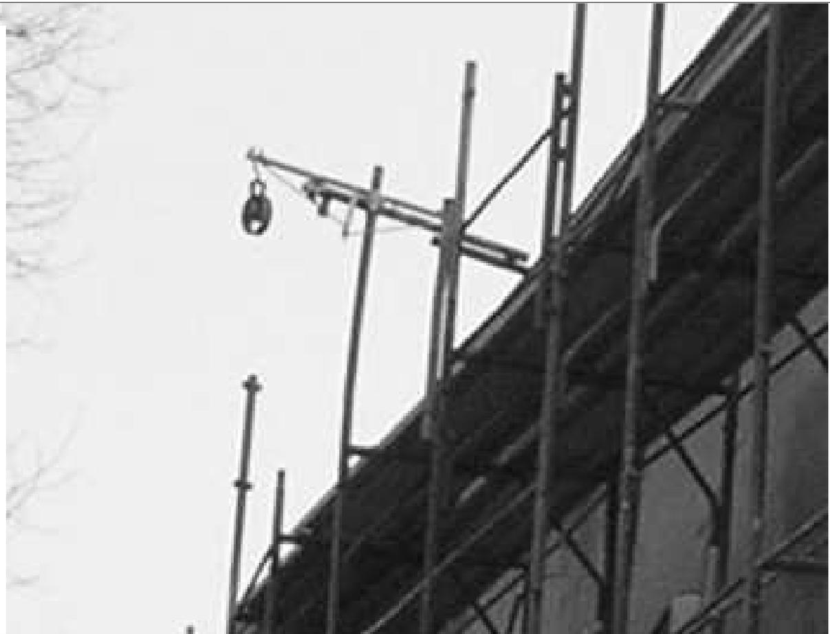
E' vietato montare sul ponteggio tabelloni pubblicitari, graticciati, teli od altre schermature a meno che non si sia provveduto all'aumento, rispetto allo schema tipo, del numero di ancoraggi e di diagonali sulla base di un calcolo, eseguito da Ingegnere o Architetto abilitato all'esercizio della professione in relazione all'azione del vento presumibile per la zona ove il ponteggio è montato (v. pt. 3.4 delle Istruzioni CNR-UNI 10012/67, D.M. 3/10/1978).
