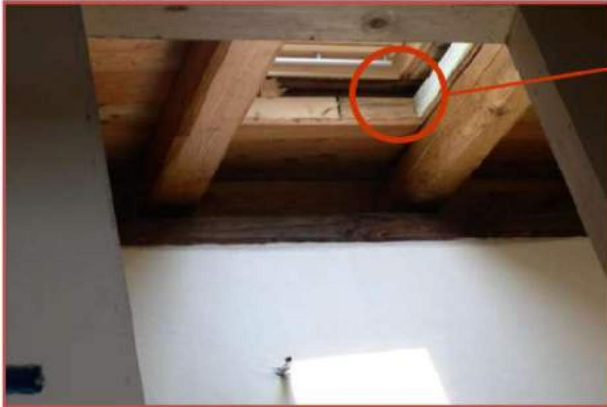
*La connessione fra il pacchetto di copertura ventilato e la finestra presenta numerosi punti di continuità (ponte acustico verso l'esterno)*
