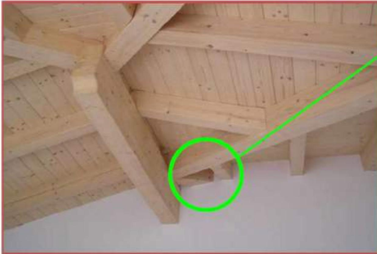
*La connessione dei punti critici fra la copertura gli elementi verticali di chiusura è stata curata in modo da non avere "indebolimenti" lungo il perimetro di contatto*
